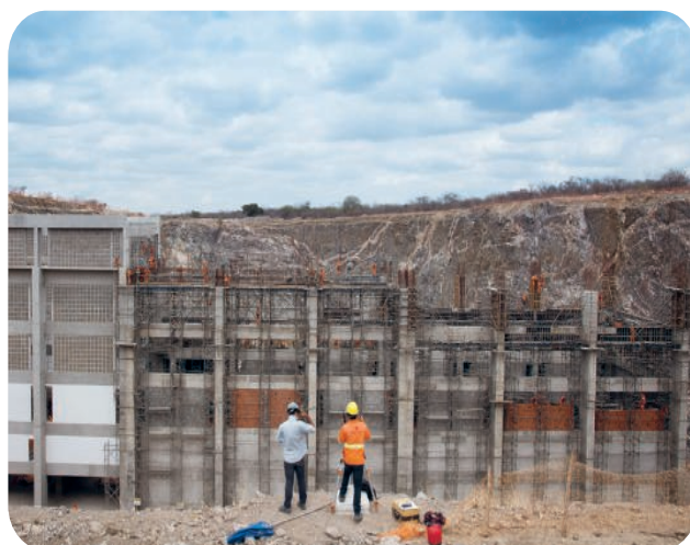
Engenheiros civis orientando a construção de galeria para a passagem de água no município de Salgueiro, no estado de Pernambuco.
