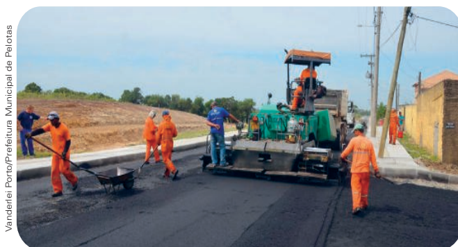
Profissionais asfaltando rua em Pelotas, no estado do Rio Grande do Sul.
