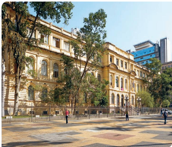
O prédio dessa escola, agora ocupado pela Secretaria da Educação do Estado de São Paulo. Foto de 2024.
